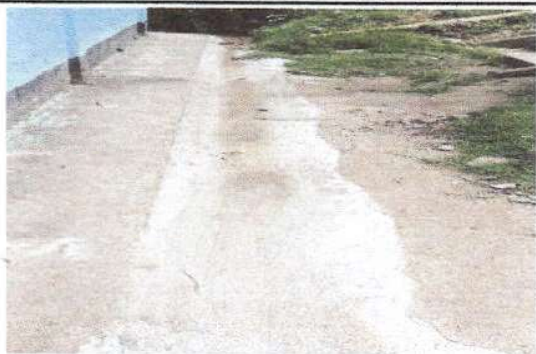
Foto 1: En la foto se puede observar al costado de la escuela
