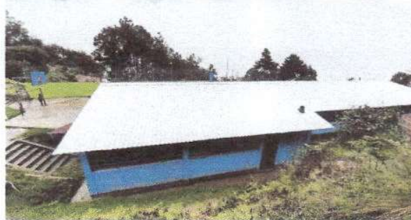
Foto 2: Se observa el aula del módulo No.2. que fue sustituida la lámina.
