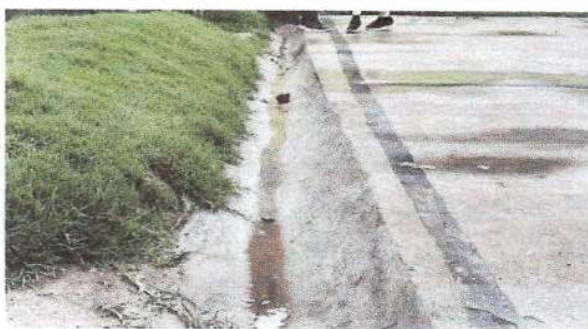
Foto 3: En la foto se observa la cuneta ya reparada de concreto.
