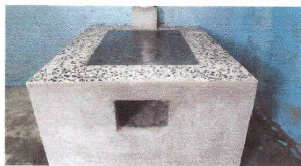
Foto 6: En la foto se observa la plancha que se sustituyó.
